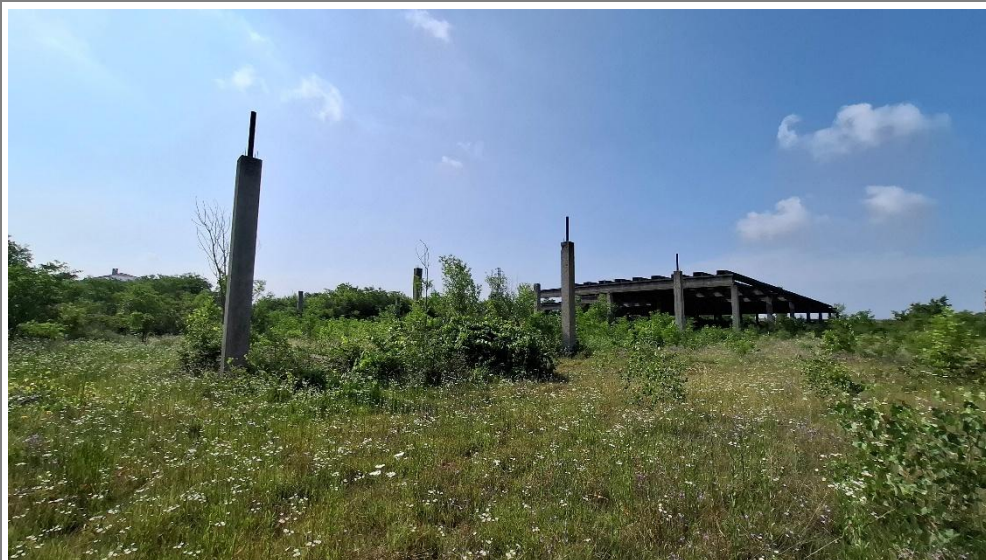
Fig. 8. Immagini dell'area d'interesse progettuale allo stato attuale: strutture dell'edificio esistente da demolire.
