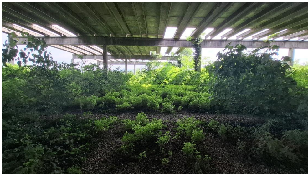
Fig. 9. Immagini dell'area d'interesse progettuale allo stato attuale all'interno dell'edificio esistente da demolire.
